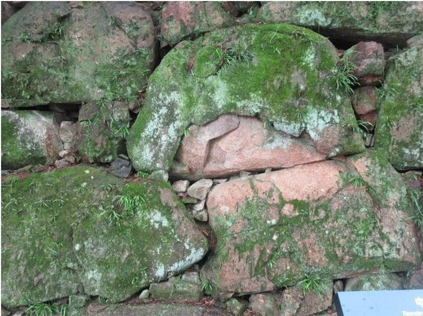
1945年の原子爆弾投下により赤く変色しひび割れている
