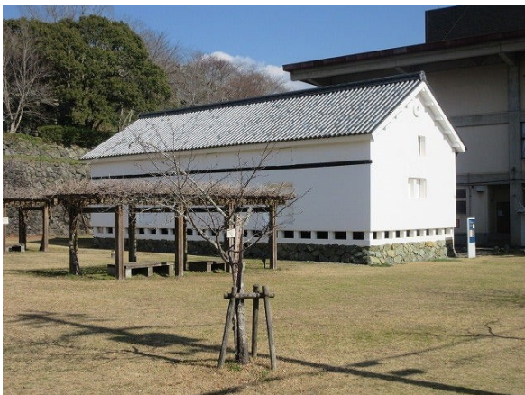
高床の土蔵風の造りになっている
