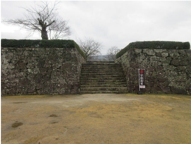
継ぎ足された石垣跡
