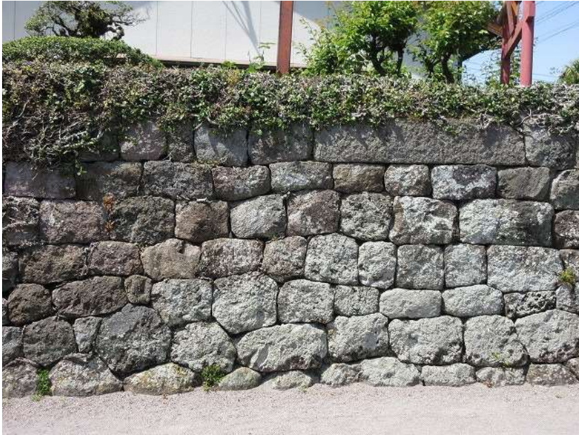
切り込み接ぎ 石垣の上には小石が置かれている
