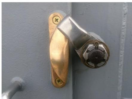
鋼材を変えて潮風でも錆びないようにしている
