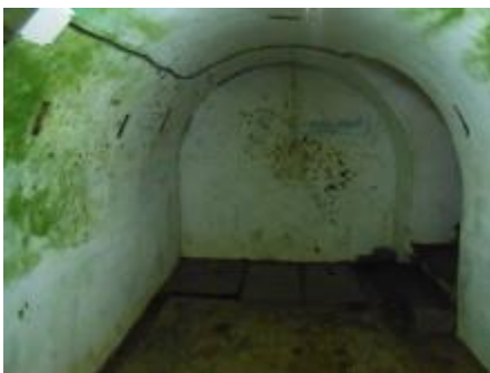
ツルハシで掘った跡
