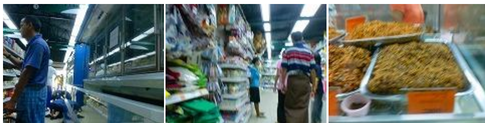
修理中の冷蔵ケース
