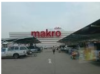
屋根付き駐車場
